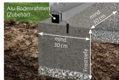
Eine weitere Möglichkeit, Gartenhäuser auf unebenem Boden aufzustellen, ist ein Punktfundament in Verbindung mit einem **Alu-Bodenrahmen**.
