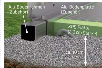
Mit dem **Alu-Bodenrahmen** können Sie das Gerätehaus auch auf einem Splittbett aufstellen und sturmsicher verankern (Bodenanker liegen bei). Die **Alu-Bodenplatte** dient als funktioneller Boden und wird mit XPS-Hartschaumplatten unterfüttert (nicht im Lieferumfang).
